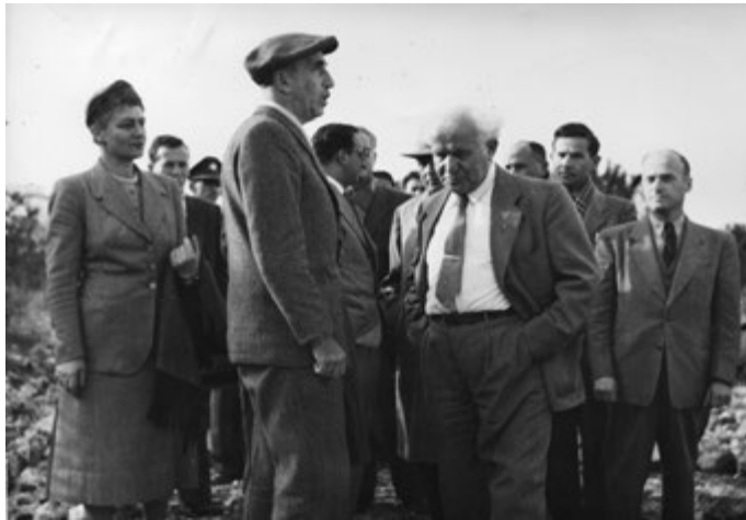
Thủ tướng David Ben-Gurion, tại công trường xây dựng cơ sở mới của Technion
